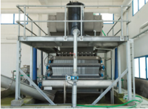
Ταινιοφιλτράτρες αβυδάτωσης λιάσης
