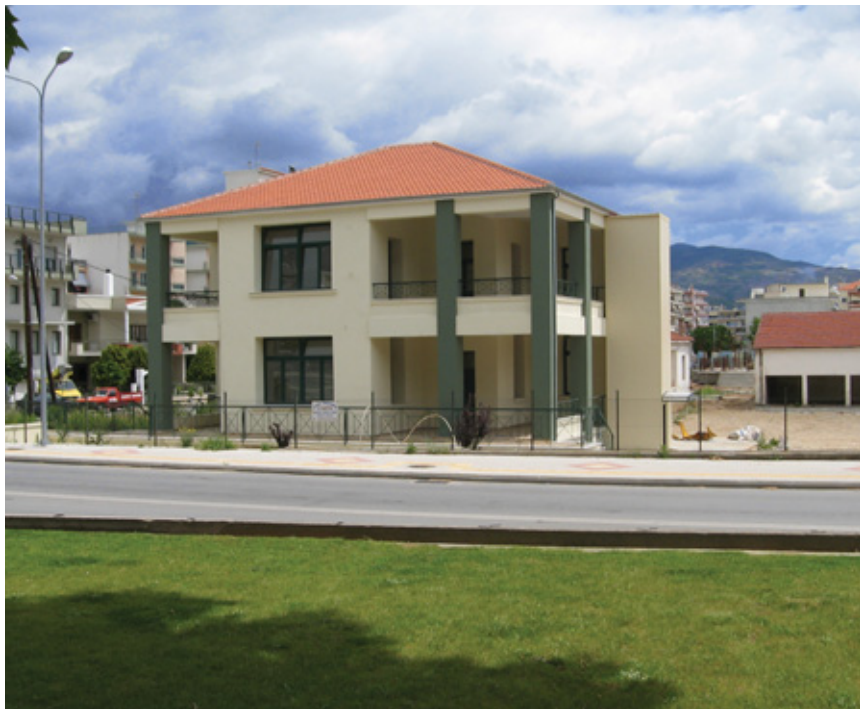
Κτίριο παλιού καπνικού σταθμού
