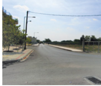
Οδός Ε. Λάμπρου - ΟΑΕΔ - Πετρελαιοαποθήκες - Δροσερό
