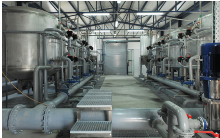
Εγκαταστάσεις συγκροτήματος φίλτρων για τη βελτίωση πόσιμου νερού
